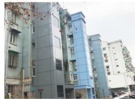
浙江杭州市杭钢北苑加装电梯
