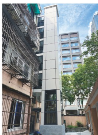
杭州市拱墅区双荡新村加装梯
