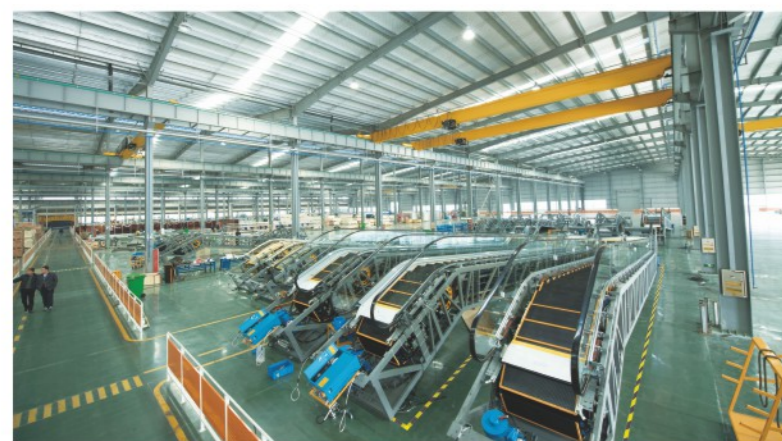
扶梯梯装配车间
